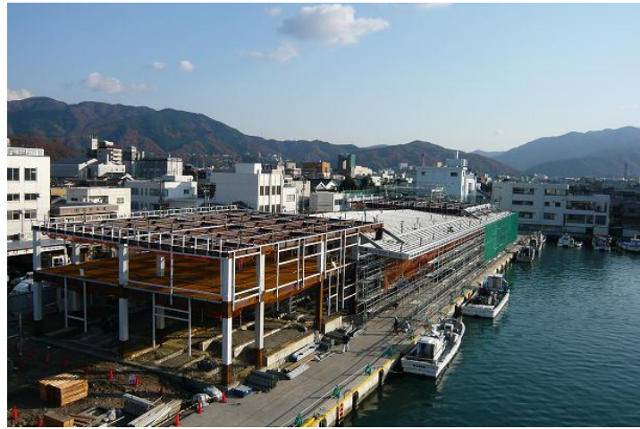
【建設中の新敦賀市場】
